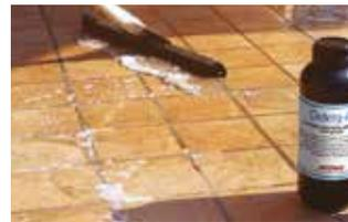
Den Säurereiniger **DETERG-A** mit der den auf der Oberfläche vorhandenen Verunreinigungen und Konkretionen entsprechenden Menge Wasser verdünnen. Die Lösung mit einem geeigneten Abzieher auf der Oberfläche verteilen. 15 Minuten warten, bis eine saure, schaumige Reaktion eintritt. Mit viel Wasser spülen.
