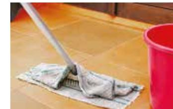
Eine Stunde nach der Anwendung alle Rückstände und Überstände des Produkts auf der Oberfläche mit einem mit Nitroverdünner imprägnierten Tuch entfernen. Die transparente, wasserabweisende, filmfreie Imprägnierung ist somit vollständig.
