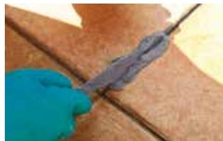
Durch die Reinigung hervorgehobene Risse und Unregelmäßigkeiten sorgfältig mit dem speziellen wasserdichten Füllstoff **STUCCO BALCONY** in Übereinstimmung mit den Fußleisten und Schwellen auffüllen. Bewegungsfugen mit **PROTECH FLEX**, dem speziellen hoch elastischen Polyurethan-Dichtstoff in extrudierbarer Kartusche behandeln.
