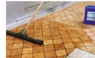
**PROTECH BALCONY** über die zu imprägnierenden Bereiche gießen und mit einem geeigneten Abzieher verteilen. Besonders auf die Fugen zwischen Fliesen und Fußleisten achten. Vor Durchführen des Oberflächenflutungstests, das Produkt mindestens eine Stunde einwirken lassen. Diese Arbeiten erst nach völligem Aushärten der Fugenmasse durchführen.
